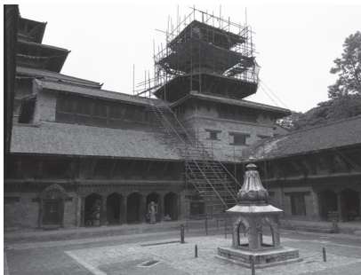
修復中のパタン旧王宮
